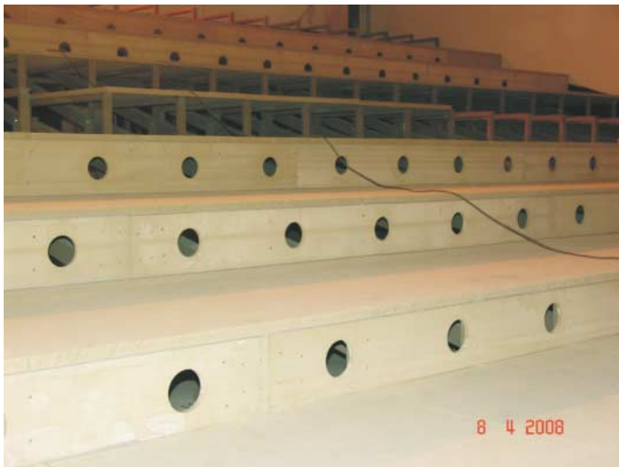
Finnkino Flamingo lattiarakenteita 37 mm sementtilastulevystä.
