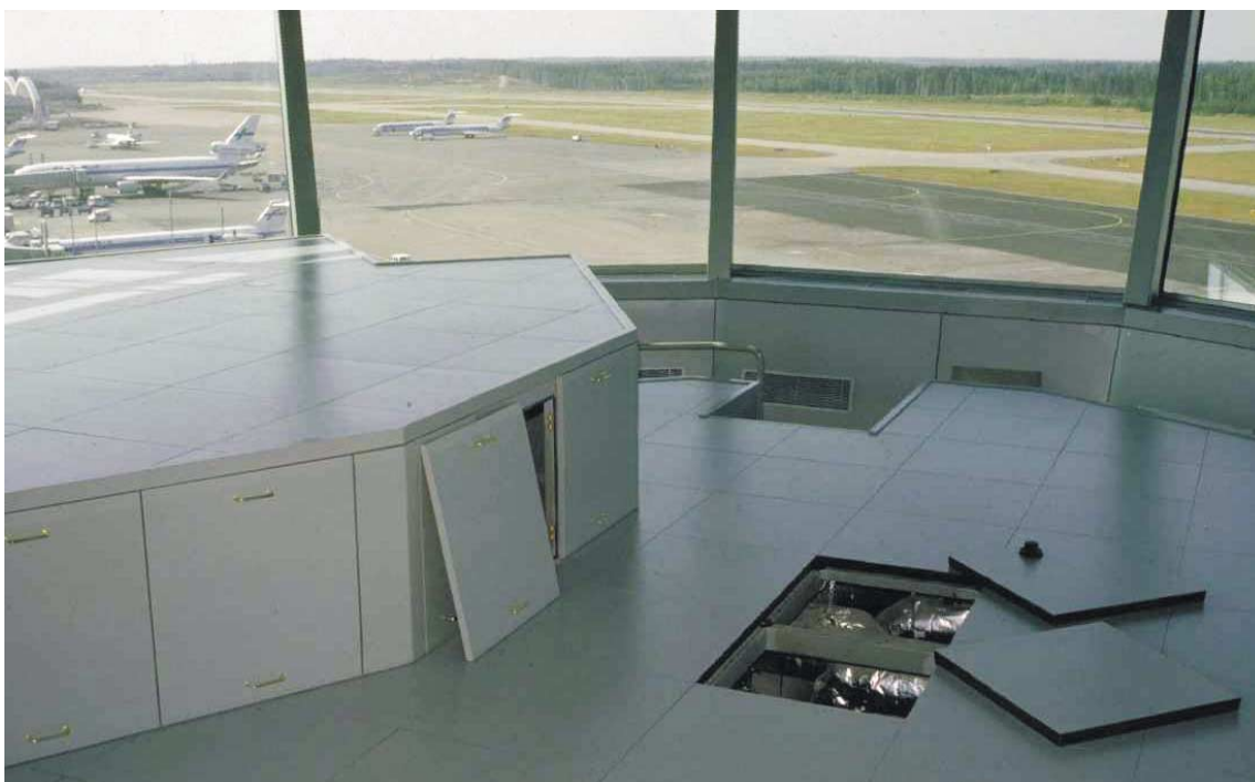
Helsinki-Vantaan lennonjohtotornin lattiarakenteita sementtillastulevystä.
