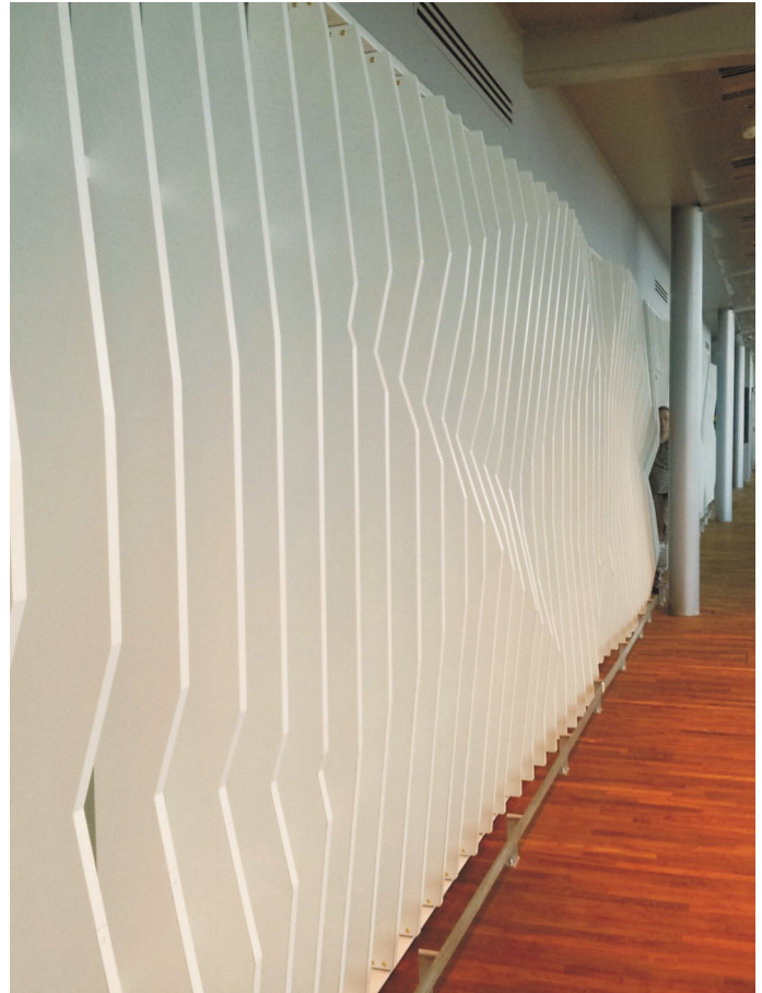
Helsinki-Vantaan lentoasema. Muotoonjyrsityt seinälamellit.
