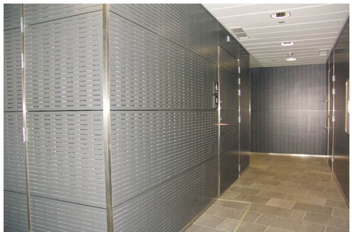
Helsingin Musiikkitalo, eri värein maalattuja Perfo-Lineaari-rei'itettyjä levyjä, musta läpivärjätty "Antrasiitti"-runkolevy.
