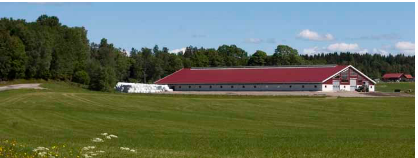
Hede gård, navetan rakennusala 3.600 m. Rakennettu vuosina 2009-10. Rakennuttaja: Conny ja Denise Karlsson. Urakointi: Åke Eriksson Bygg. Rakennuskonsultti: Bygglant.
