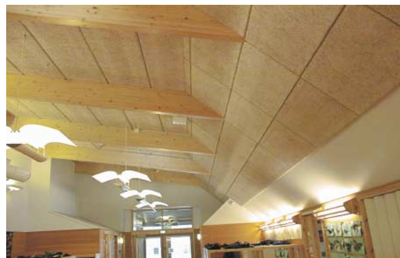
T-tak kattorakenne, Lastentarha, Leppävaara.
