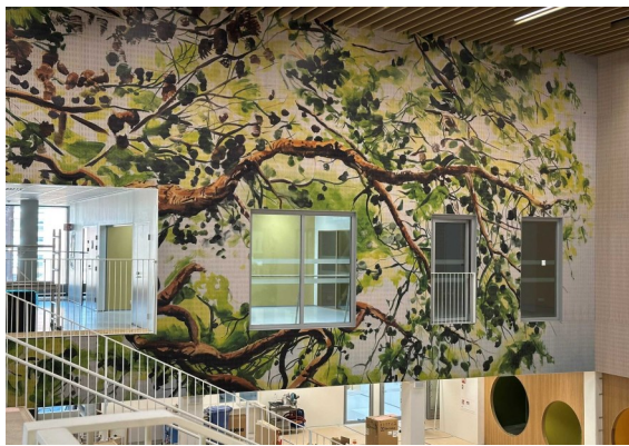
Rykmentipuiston koululla tammiviilutettua Perfo-Lineaari levyä digiprintattuna.
